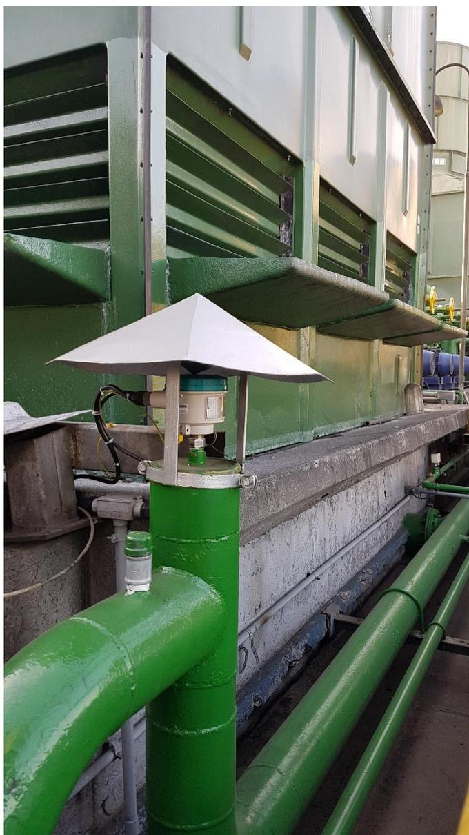
Figura 68 – Sensor Extravador do Tanque Superior (Atual)
