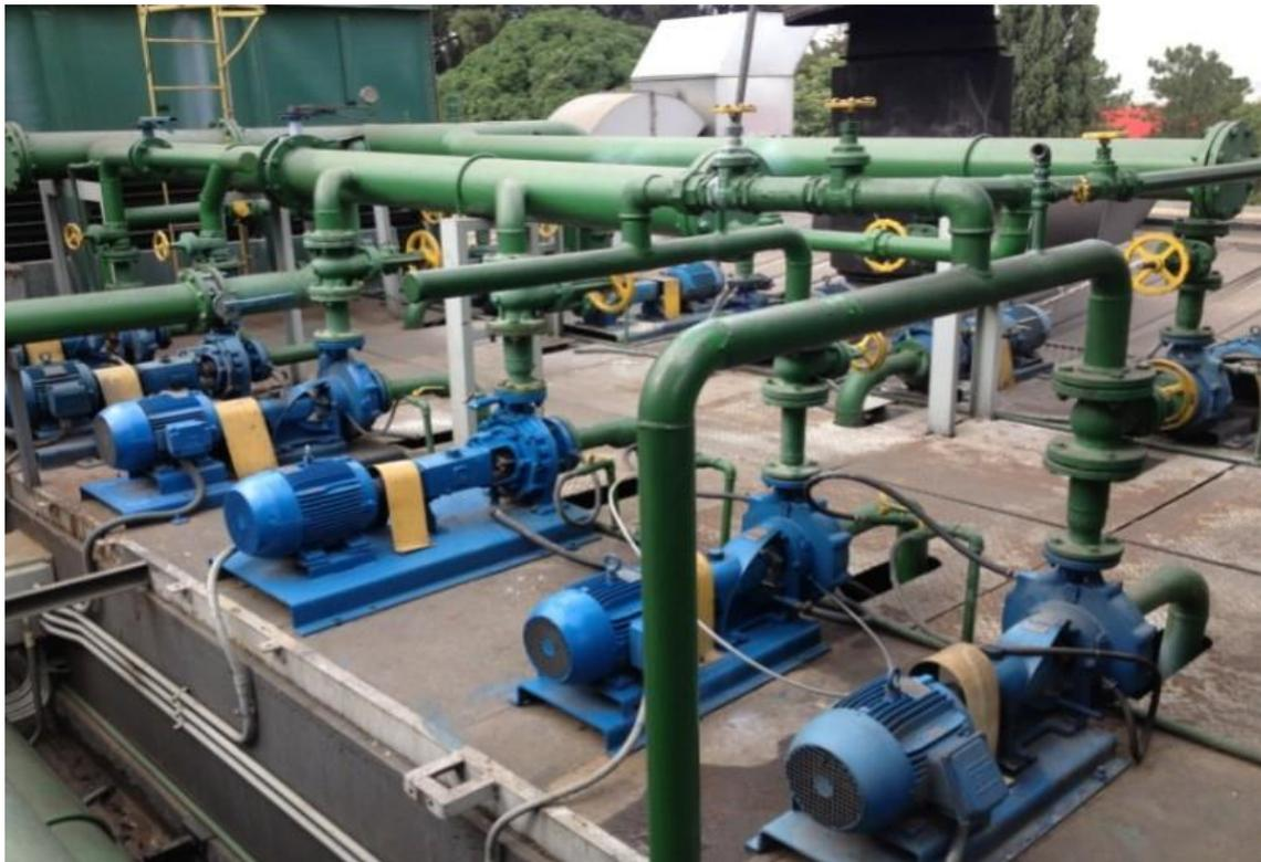
**Figura 8– Bombas de captação de água localizadas sobre o tanque superior (3º pavimento prédio)
