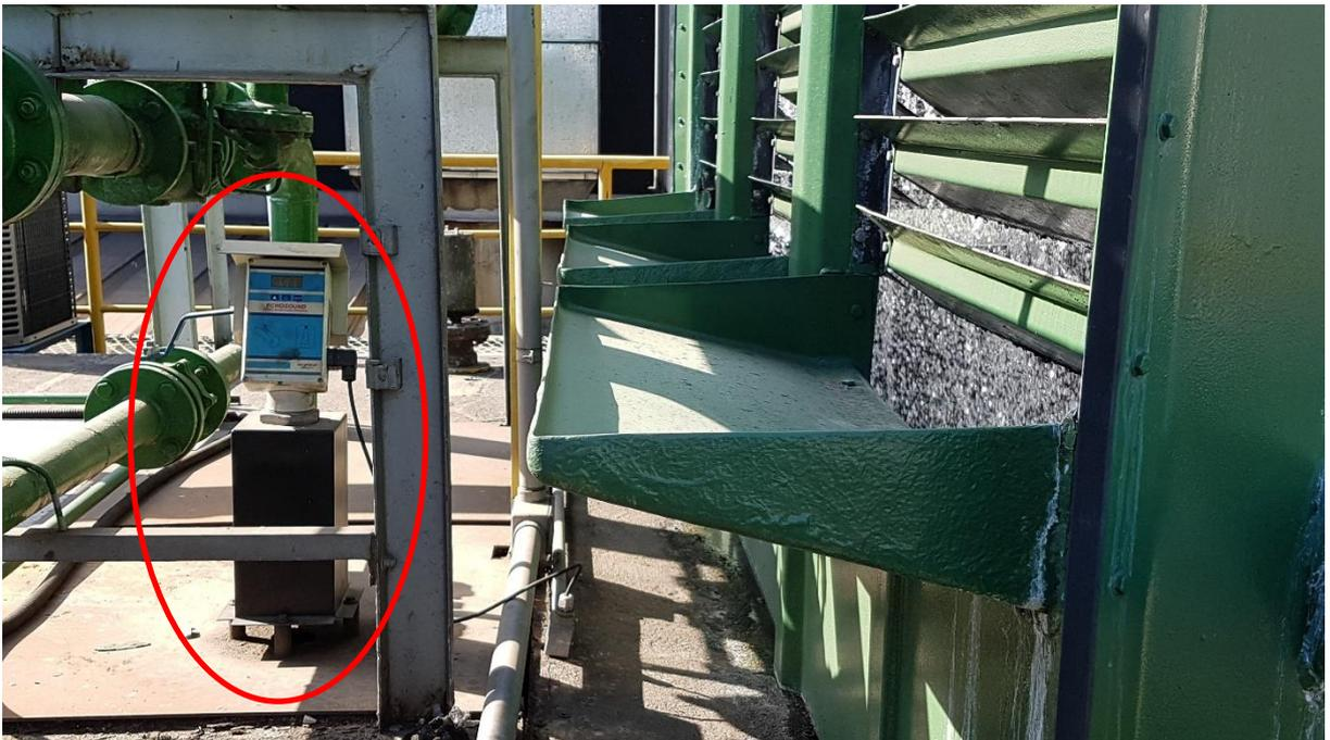
Figura 66 – Sensor de Nível (ultrassônico) do Tanque Superior
