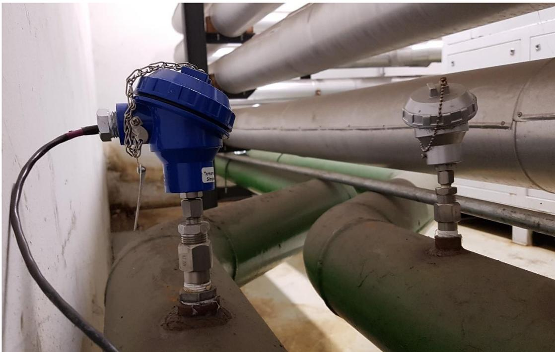
Figura 64 – Sensores de Temperatura PT-100 instalados nas Tubulações do Processo (Atual)
