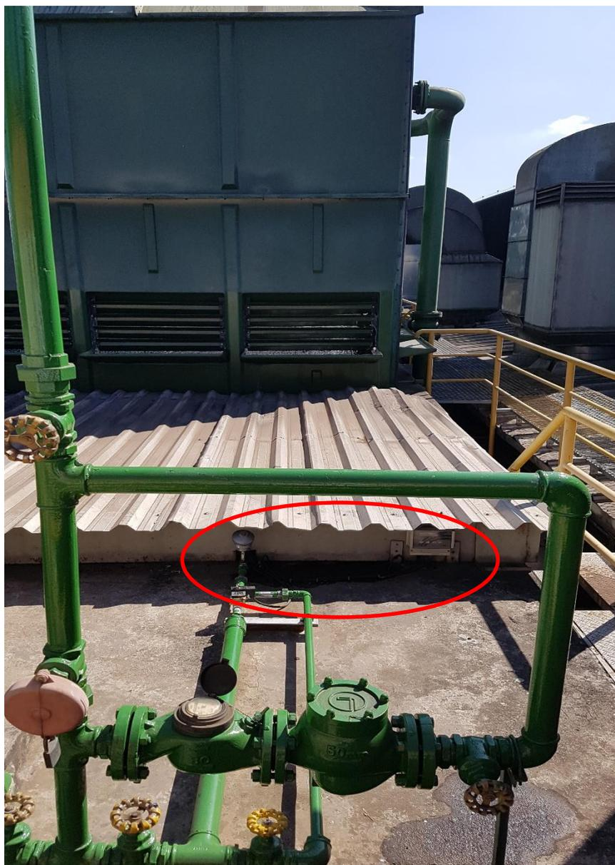
Figura 67 – Sensor de Vazão Volumétrica instalado na Tubulação de *Makeup* (Atual)
