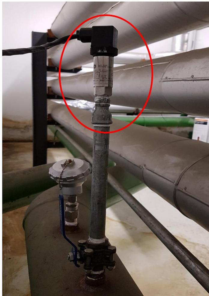
Figura 62 – Transdutor de Pressão Instalado no Processo (Atual)
