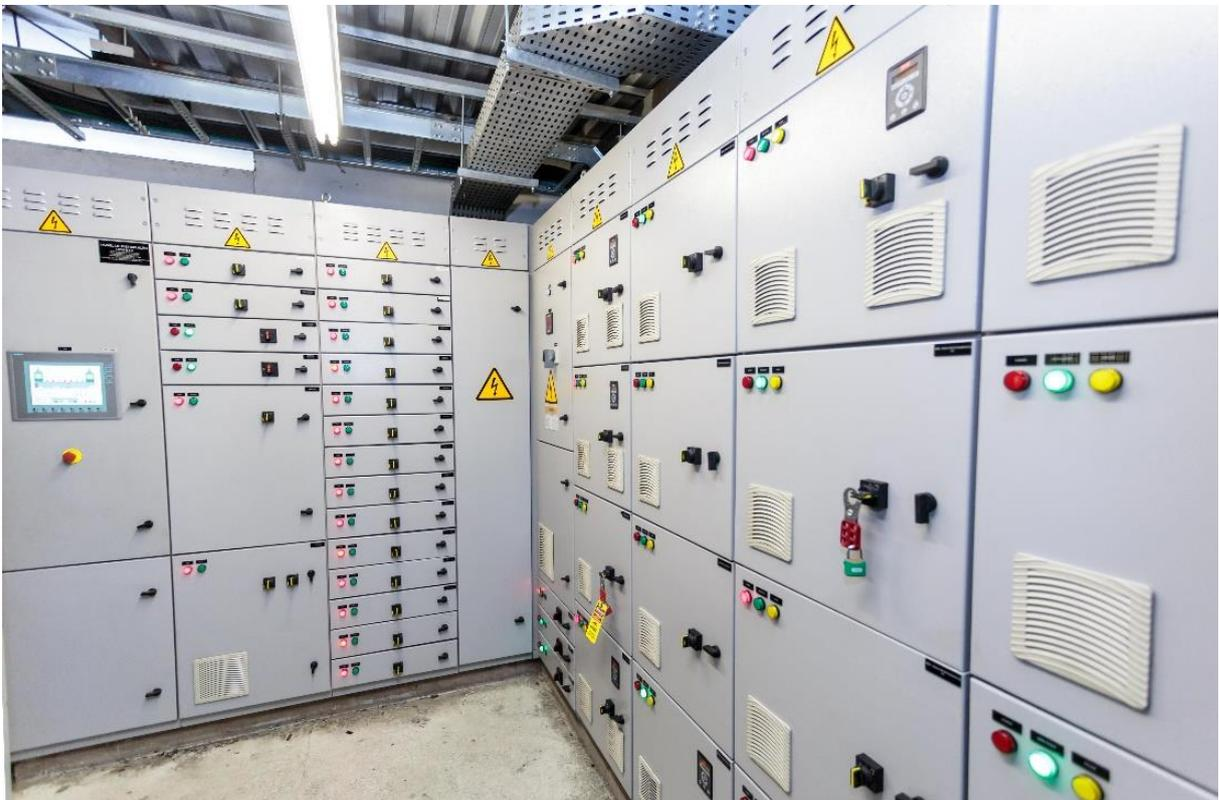
**Figura 61 – Novo CCM Fabricado Formato 3B (Atual)**
