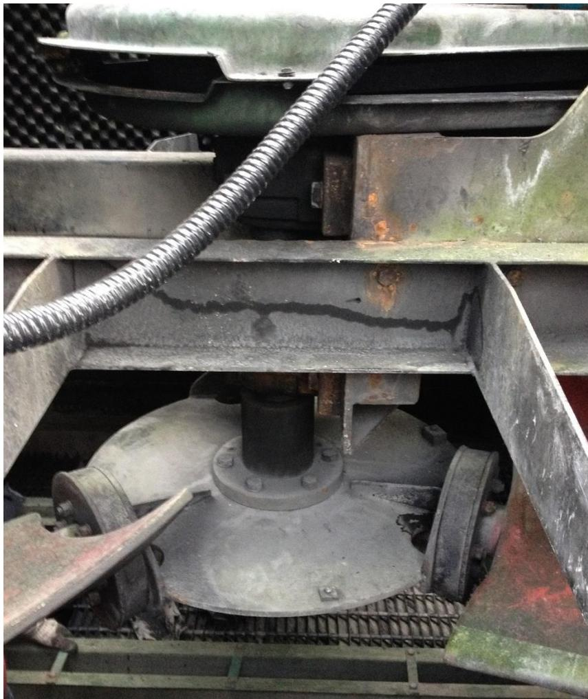
**Figura 91 – Conjunto de Acoplamentos e Redutores para Acionamento dos Ventiladores das Torres**
