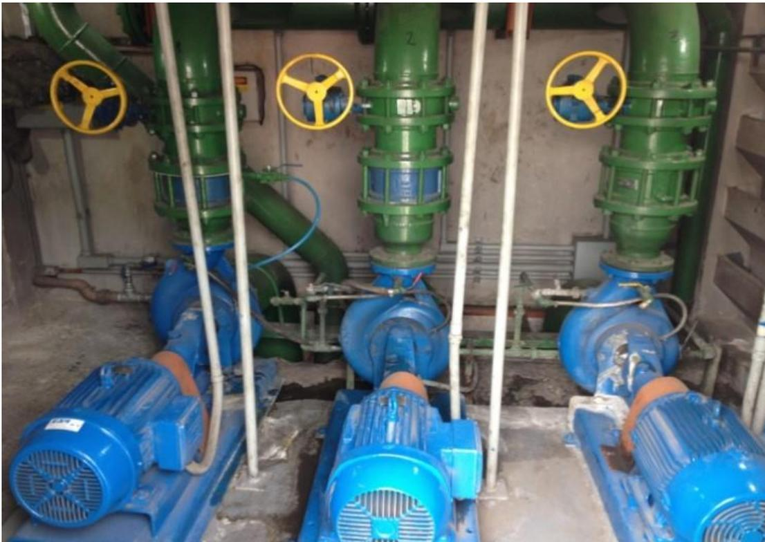
**Figura 9 – Bombas de Captação de Água localizadas no Tanque Inferior (1 pavimento)**
