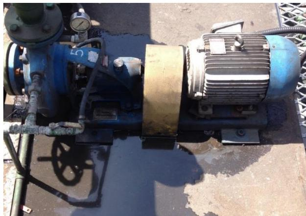
Figura 108 – Vazamento de Água em Excesso (Bombas Antigas do Sistema)
